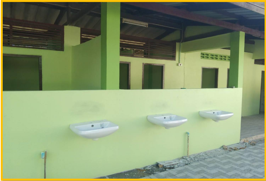
ห้องน้ำโรงเรียนบ้านอ่างเตย ปรับปรุงซ่อมแซมให้มีอ่างล้างมือ สบู่เหลว และเจลแอลกอฮอล์ เพื่อป้องกันการแพร่ระบาดของโรคติดเชื้อไวรัสโคโรนา ๒๐๑๙
